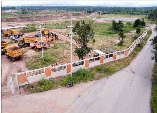
รูปที่ 1-21 ความก้าวหน้าการก่อสร้างงานรั้วคอนกรีตบล็อกเหล็กดัด ความยาว 170 เมตร
