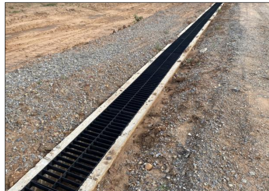
รูปที่ 1-20 ความก้าวหน้าการก่อสร้างงานวางระบายน้ำ
